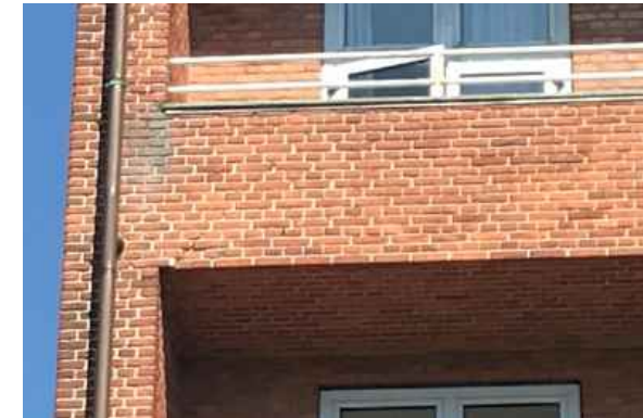
Figur 42 Særligt hjørne ved underkant af brystningsmur og loft over underliggende altan kan være kritisk.
