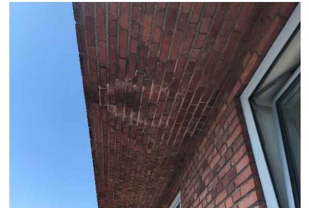
Figur 45 Misfarvning af murværk kan skyldes gennemsivning af vand.
