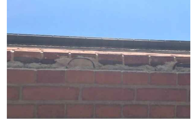
Figur 43 Hjørne ved underkant af brystningsmur og loft kan være kritisk. Her ses rust i armering, som forbinder betonplade til mursten i hjørne.
